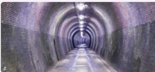
1/現在は自動車道路となっている山中トンネル 2/ほぼ直線が1km以上続く。内部はレンガ積み
